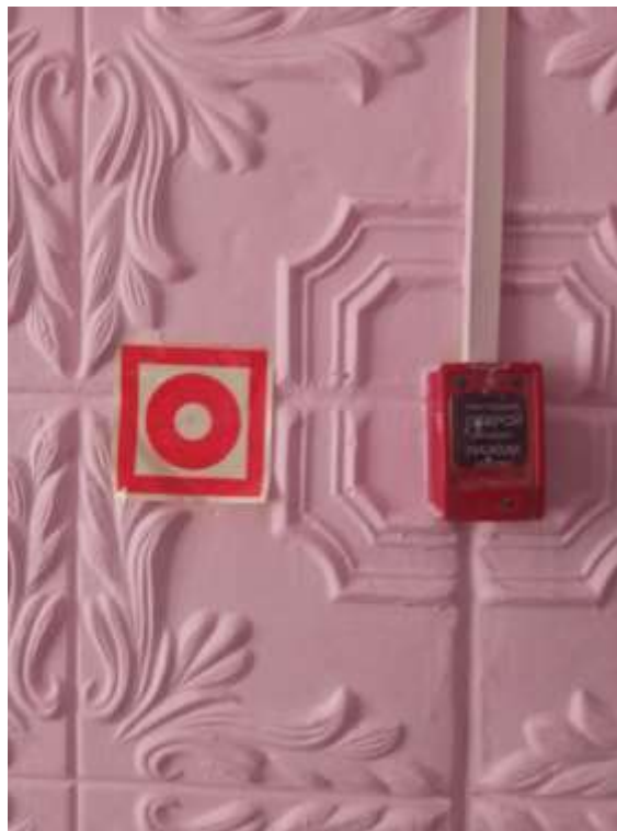
Фото № 20 визуальные средства путей эвакуации
