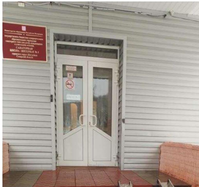
Фото №8 Дверь (входная)
