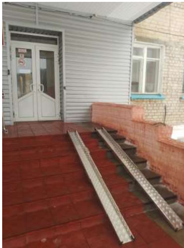
Фото № 5 Лестница (наружная)
