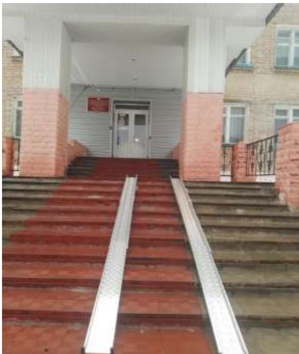
Фото №3 Лестница (наружная)
