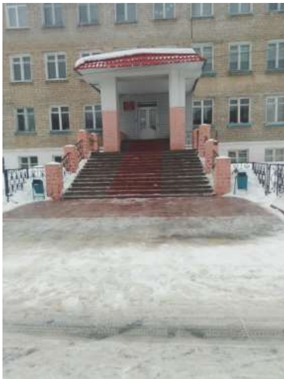
Фото №7 Входная площадка (перед дверью)
